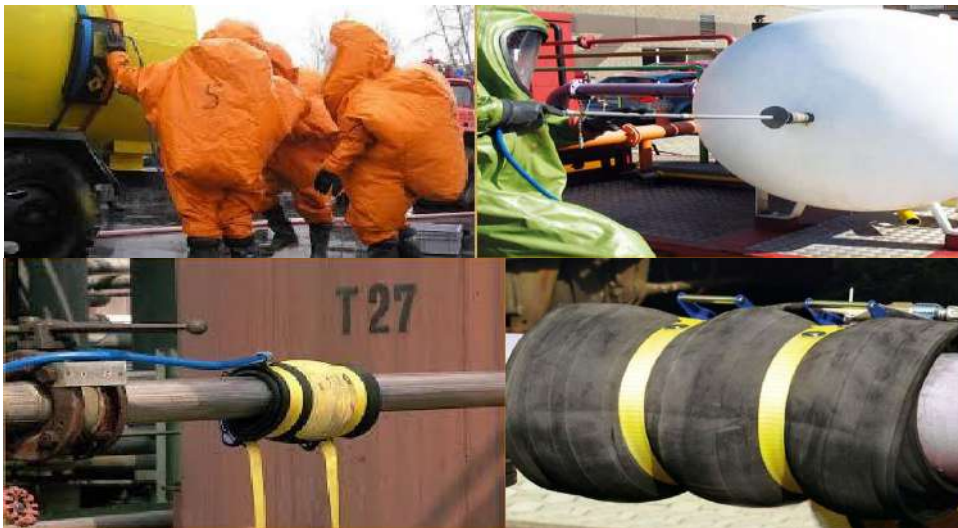
Рис. 3.12. Установки аварійних накладок
