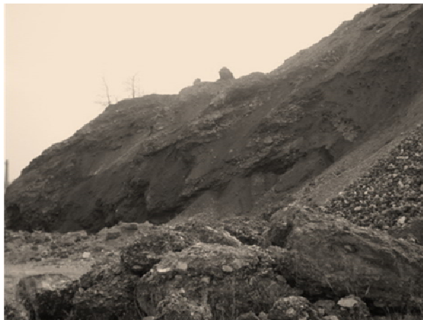
Рис. 1. Зсуви на териконі «Шахти №9» Нововолинського гірничопромислового району
